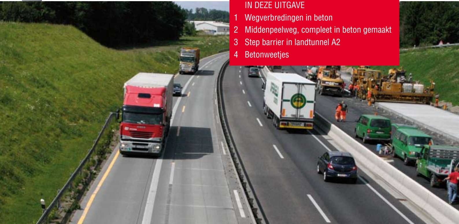
Wegverbreding omgeving Keulen; links is de verbreding gereed, rechts is de aanleg aan de andere weghelft te zien
