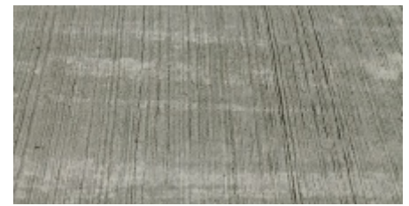
Blijvende stroefheid met een fijne bezemstreek dwars op de rijrichting
