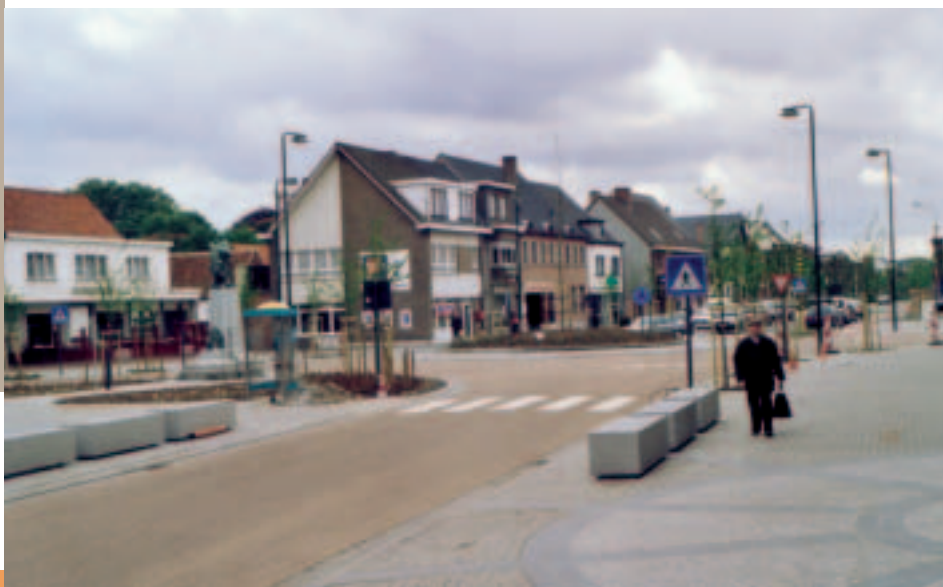
◀ Centrum Ertvelde met roodbruin beton op hoofdrijbaan en rotonde
