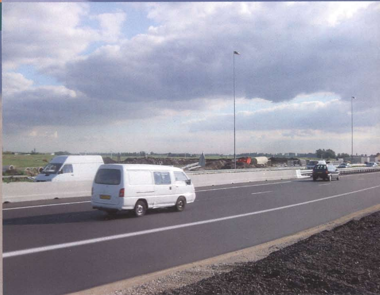
▲ Betonnen voertuigkering in de middenberm van de A4
