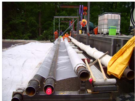
Fig. 3 Aanbrengen van de plasticfolie
