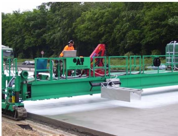
Fig. 2 Aanbrengen van de oppervlakvertrager
