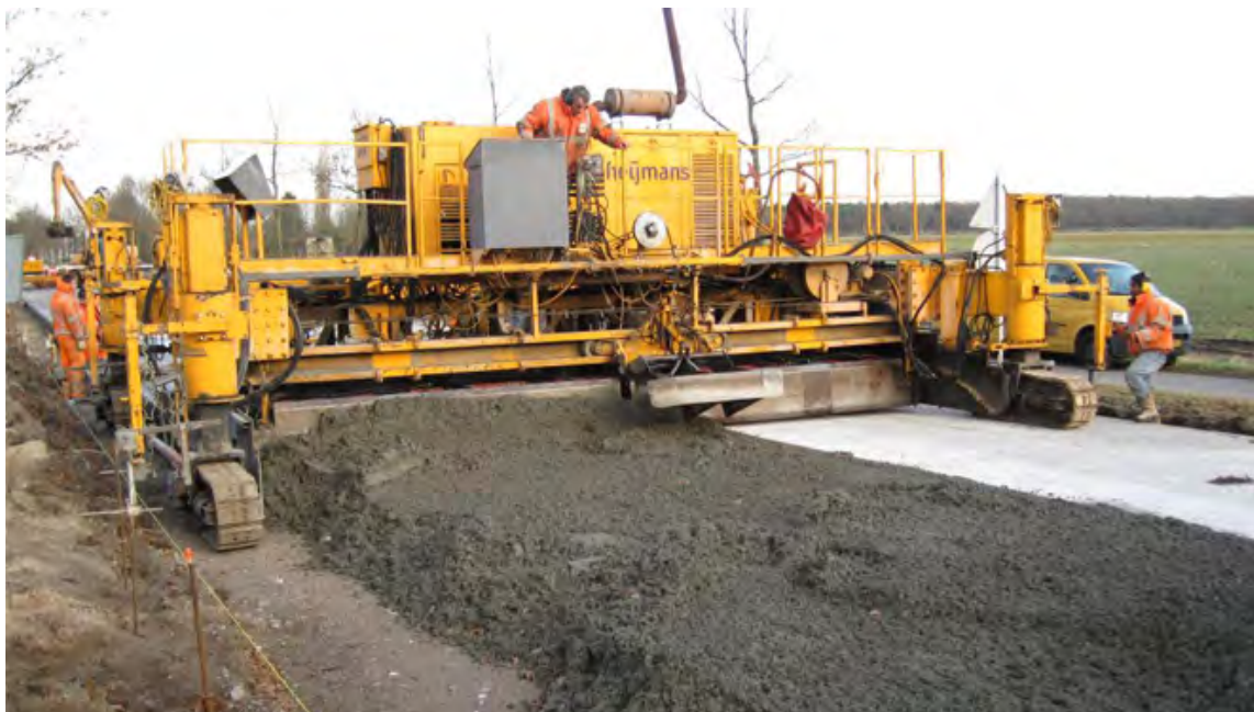
Bij de aanleg van een betonweg wordt de betonspecie gespreid en verdicht met een slipformpaver
