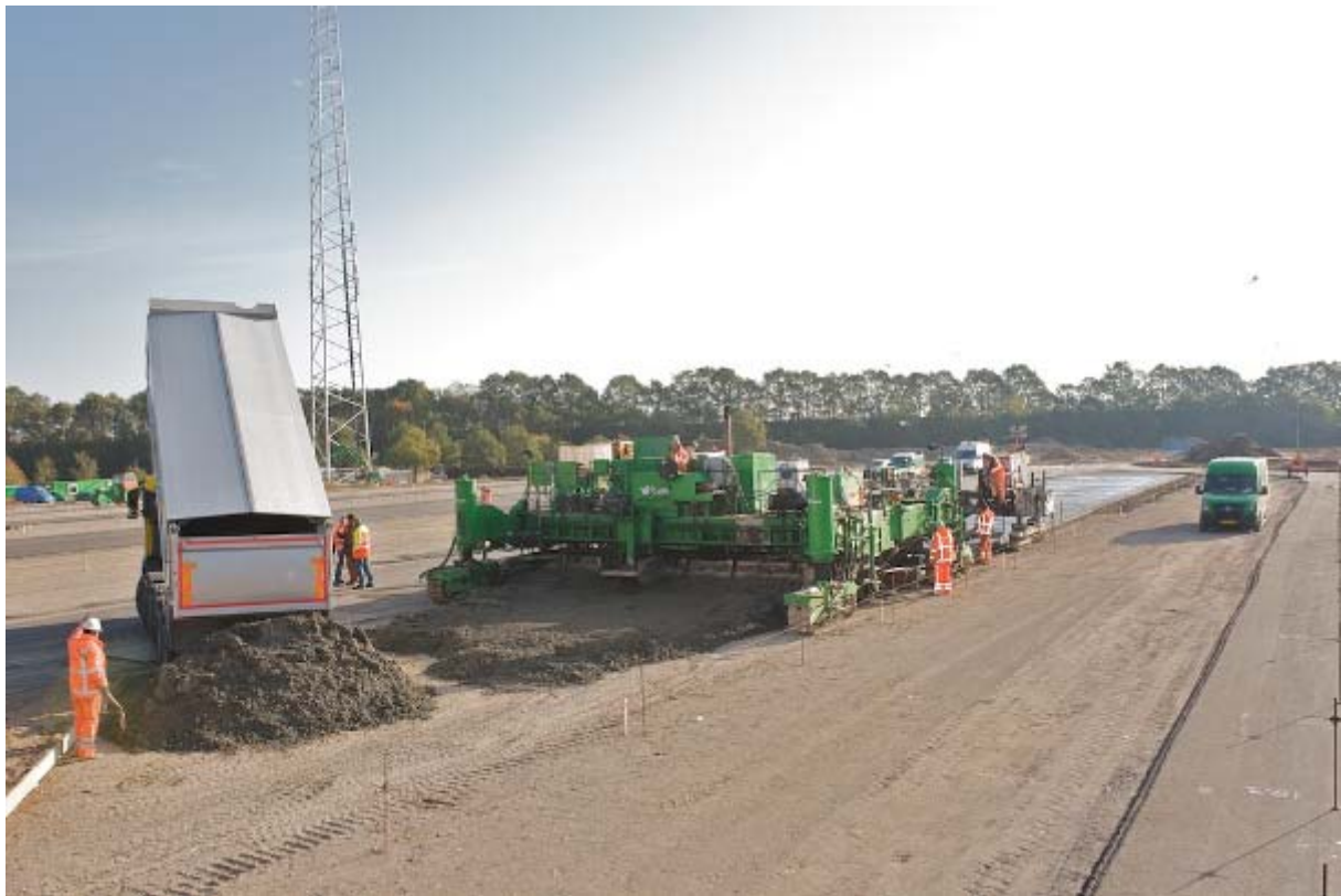
Bij aankomst op het werk wordt de specie voor de slipformpaver gestort.
