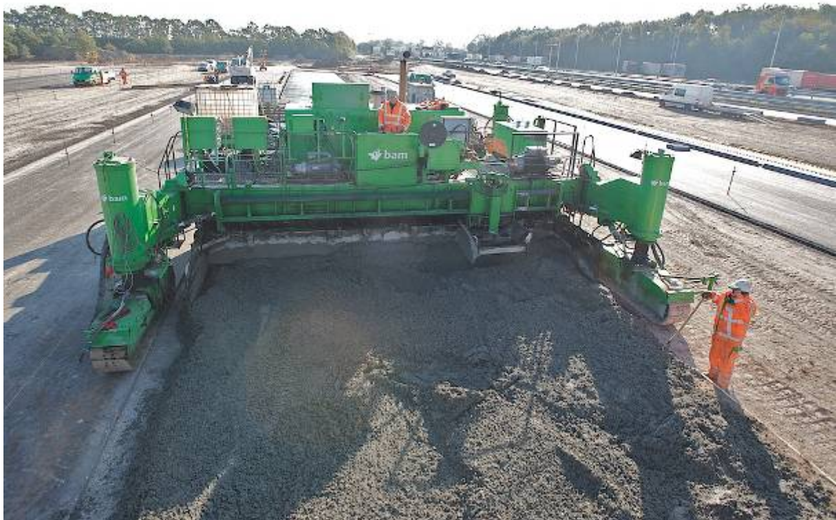
Voldoende aanvoer van betonspecie is van belang voor de voortgang van het werk.
