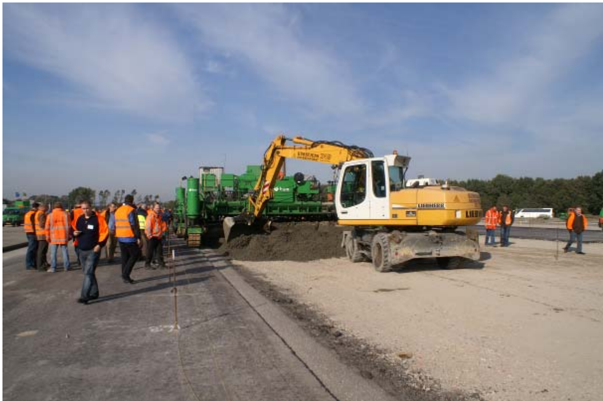
Een kleine mobiele kraan verdeelt de specie in juiste hoogte voor de machine.
