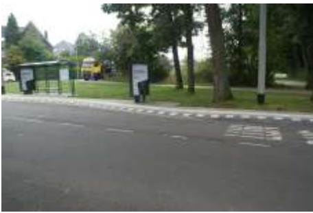
Verhoogde en verdiepte perronband in één oplossing
