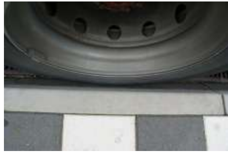
Deze vorm perronband voorkomt schade aan de wang van de band
