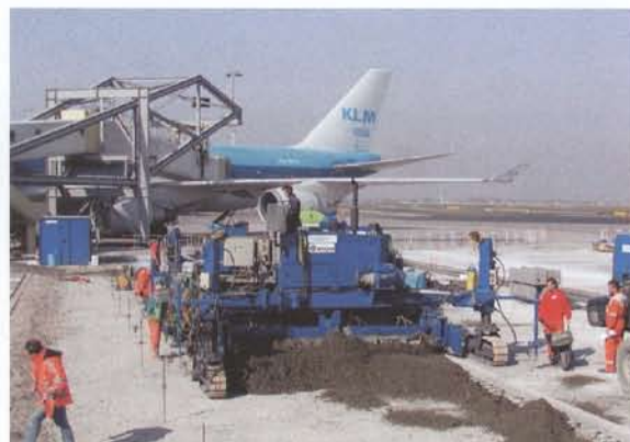
Aanleg van een betonplatform
