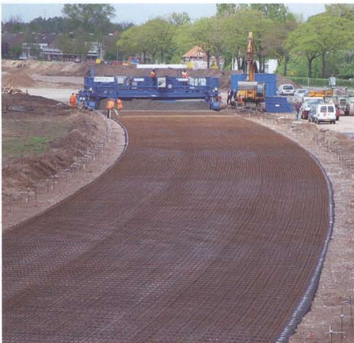
De A50 in uitvoering: een gloednieuwe slipformpaver in actie bij Sint Oedenrode.
