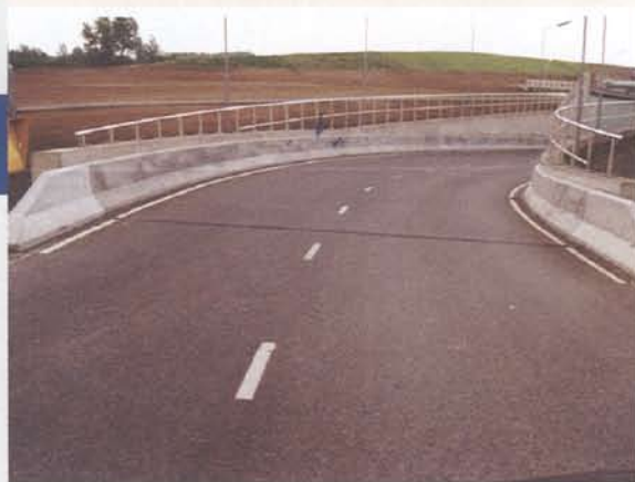
Betonnen voertuigkering op een kunstwerk
