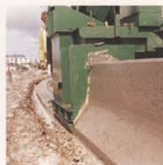
Uitvoering met slipvormpaver
