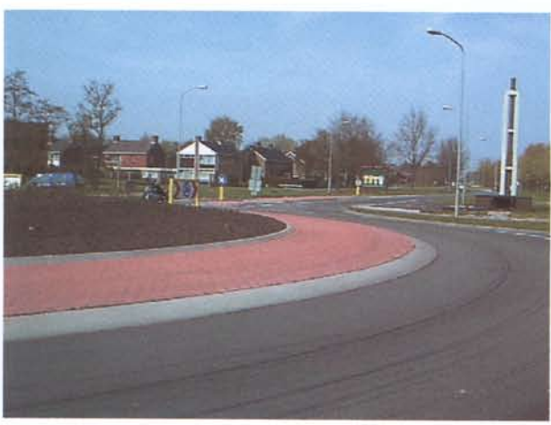
De met de slipformpaver getrokken band op een nieuwe rotonde te Delfzijl.
